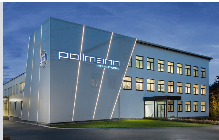
位于奥地利Karlstein的珀尔曼国际总部
