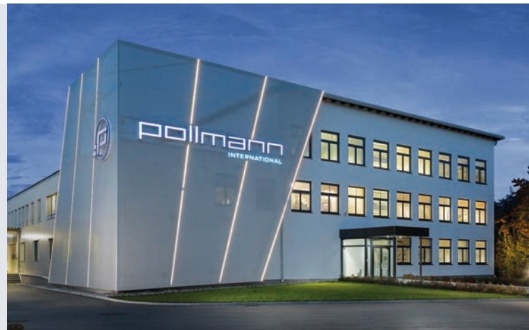
位于奥地利Karlstein的珀尔曼国际总部
